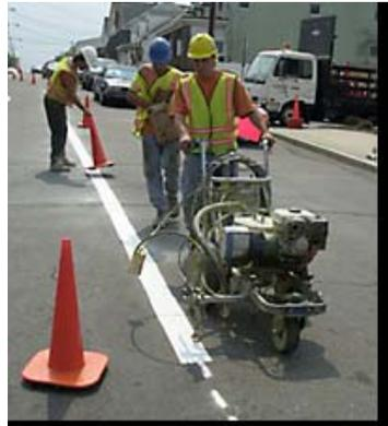
**Figura 1: Rifacimento convenzionale di linee stradali**
